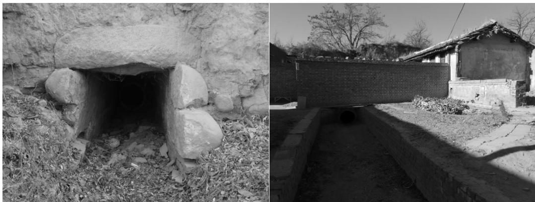
图 7-13 延庆区双营村城西排水沟及出水口
